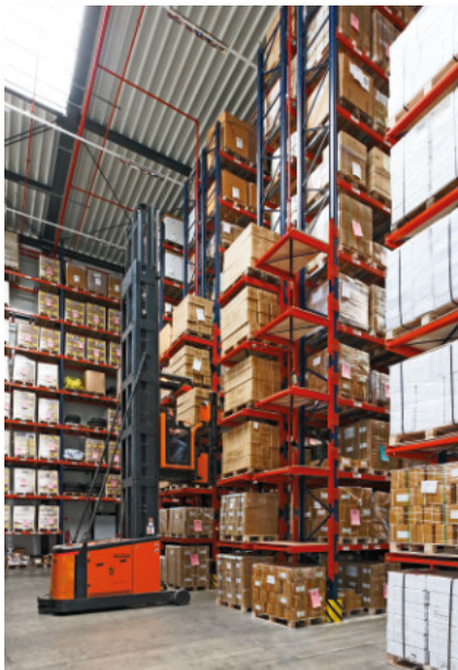
L'entrepôt de grande hauteur
