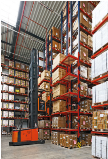
L'entrepôt de grande hauteur
